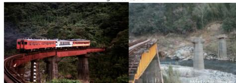
Fig3. 第二五ヶ瀬川橋梁(被害前) Fig4. 第二五ヶ瀬川橋梁(被害直後)
